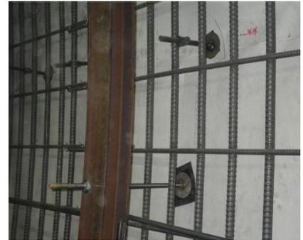
写真3 プレート付ボルトによる固定
