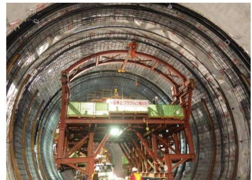
写真4 鉄筋台車
