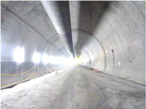
図 5 覆工コンクリート全景
