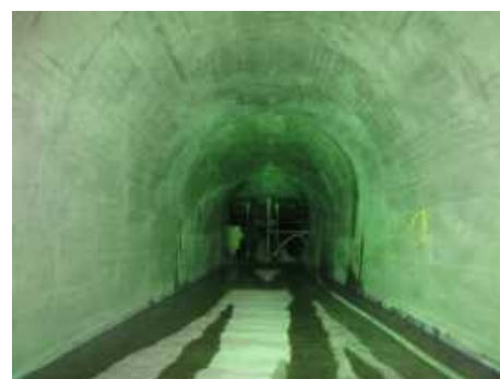
写真-3 仕上がり状況
