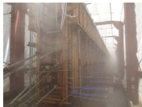
写真-1 ミスト養生の実施状況
