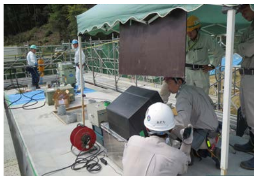
写真-2 高槻インターチェンジ緊張状況
