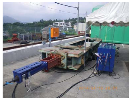
写真-1 試験緊張状況
