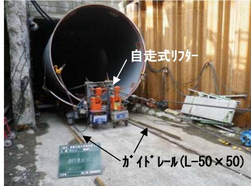
写真-1 巻込鋼管運搬状況
