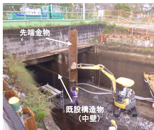
写真-1 既設構造物廻りの施工状況
