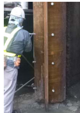
写真-3 ケミカルアンカー施工状況
