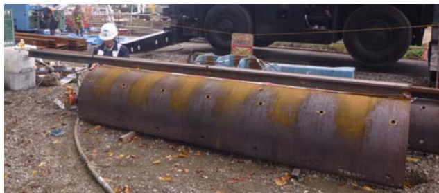
写真-2 鋼矢板継手付先端金物
