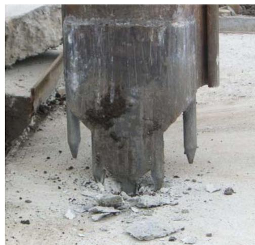
写真-2 チゼル付鋼矢板試験施工状況
