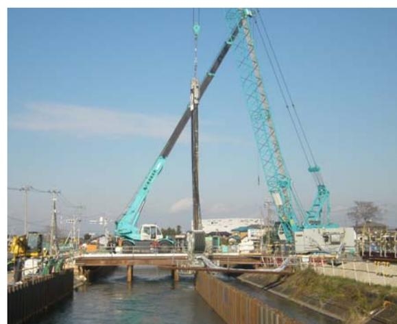
写真-6 オーガ削孔時の施工状況
