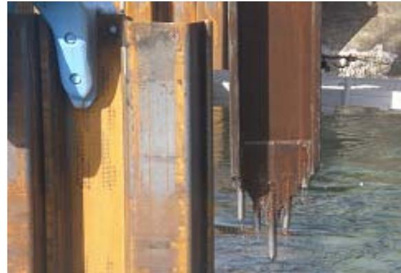
写真-3 チゼル付鋼矢板施工状況
