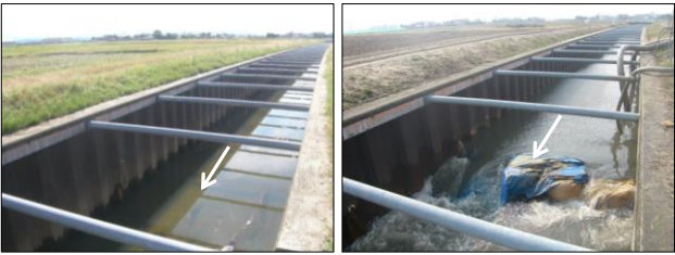
写真-4 平常時の実測流量 0.3\text{m}^3/\text{s} 降雨時の実測流量 3.1\text{m}^3/\text{s}
