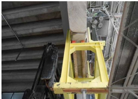
写真-4 ワイヤーソーイング施工状況
