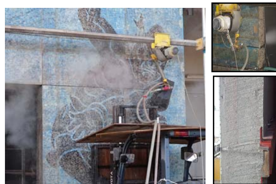
写真-3 ウォータージェット施工状況
