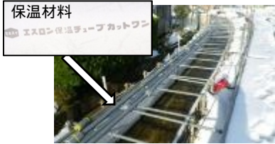
写真-3 地上配管保温状況
