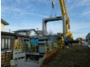
写真-2 施工状況
