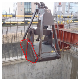
写真-4 錘を取付けたクラブバケット
