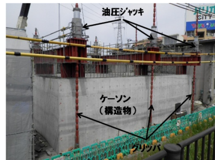
写真-2 ケーソン圧入状況
