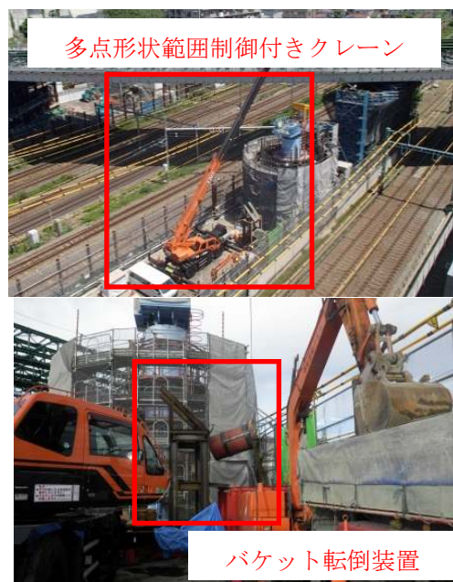
写真-2 施工状況
