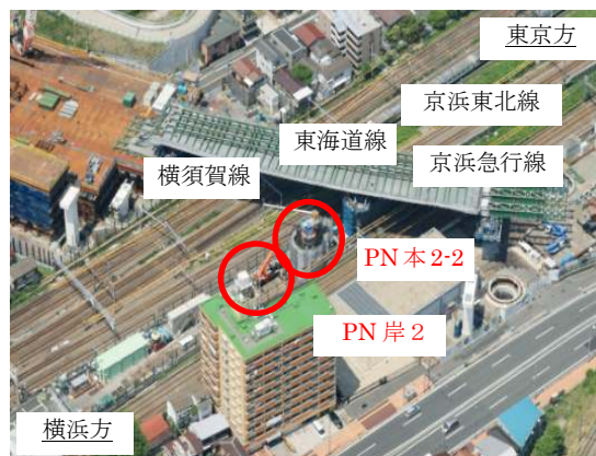
写真—1 現場全体
