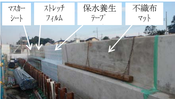
写真 1 各種養生材による養生状況
