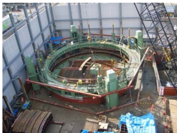
写真-2 リング組立状況
