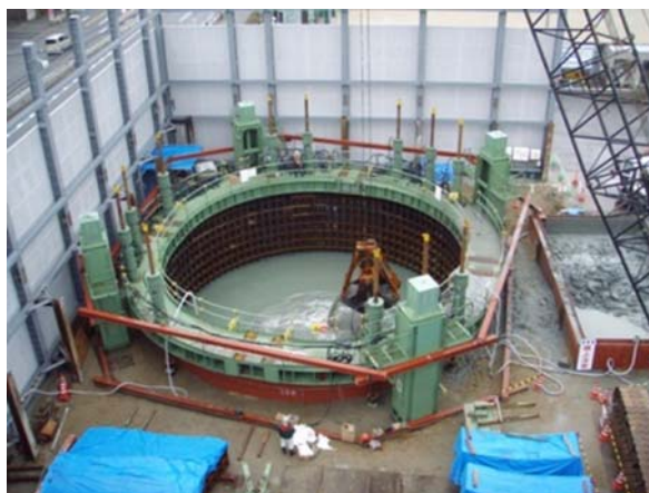
写真-1 圧入掘削状況
