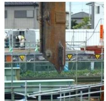
図-11 先行破砕鋼矢板
