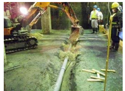
写真－2 下部通水管
