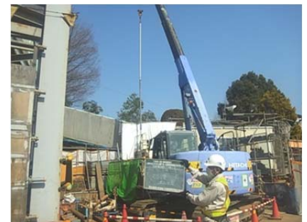
写真－3 切削状況
