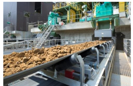
写真－3 破碎後ベルトコンベヤで搬送 (搬送能力 6,000t/h)
