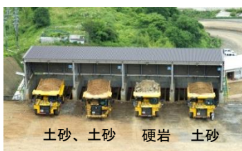
写真－4 盛土材の種類別に破砕機に投入（ダンプ台数を管理）
