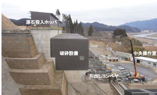
写真-2 破碎設備全景
