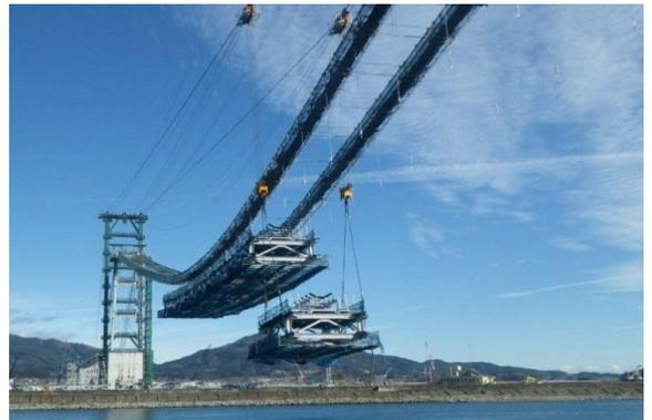
写真-2 ケーブルクレーンによる吊橋架設
