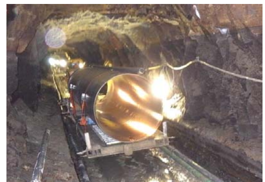
写真2 FRPM 管坑内運搬状況
