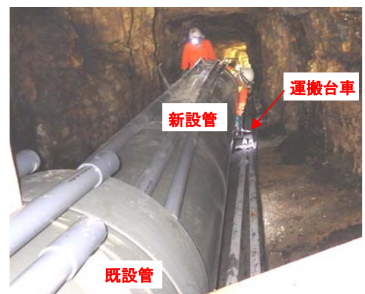
写真3 FRPM 管坑内接続状況
