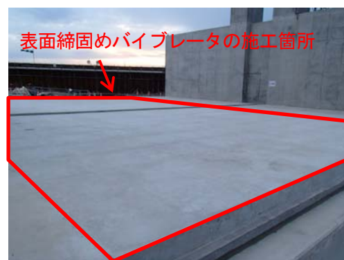
図 4 施工後の外観
