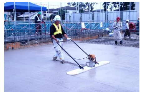
図1 表面締固めバイブレータ施工状況
