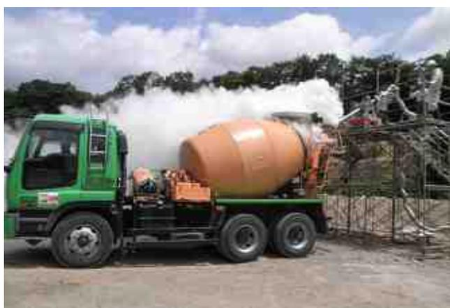
写真-1 液体窒素投入状況
