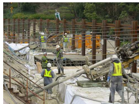
写真-1 削孔状況
