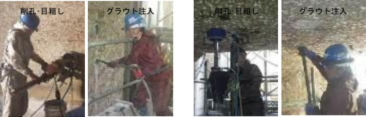
図-4 施工状況（横向き施工） 図-5 施工状況（上向き施工）
