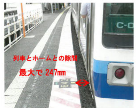
写真-1 大多羅駅 (列車とホームの隙間状況)
