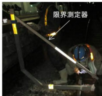
写真-5 限界測定状況
