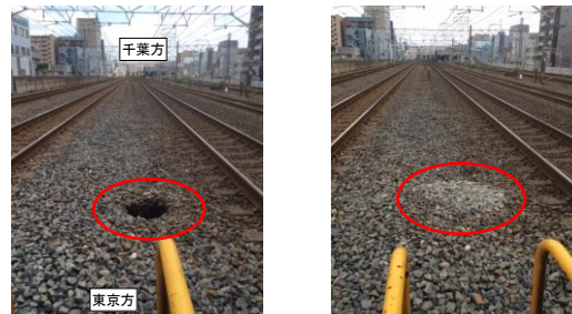
図 2. 現地写真(埋戻し前後)
