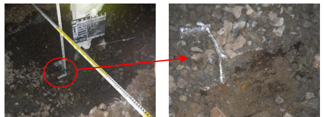
図 6. 試掘工事の様子
