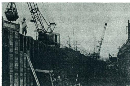
図 5. 船橋・津田沼間半地下部掘削
