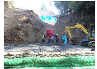
図 13. 砕石投入状況
