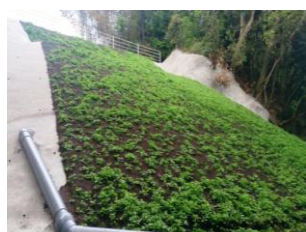
図 10. 厚層基材吹付
