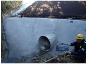
図 4. 暗渠設置及び改良土埋戻し コンクリート吹付
