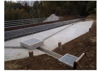
図 11. 線路側溝改良
