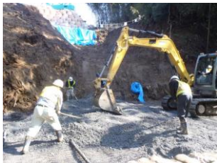
図 7. 盛土敷均し状況
