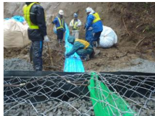
図 8. 排水ドレーン設置
