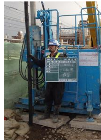
【排泥誘導管設置状況】
