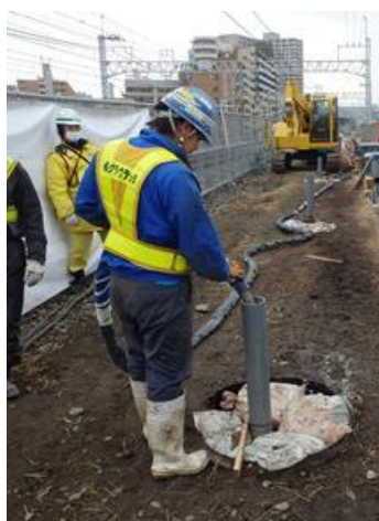
【セメントベントナイト注入】
