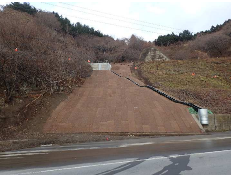
写真-2 復旧工事完了
