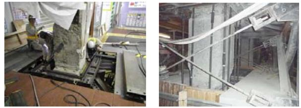
写真-1 仮受工施工状況
