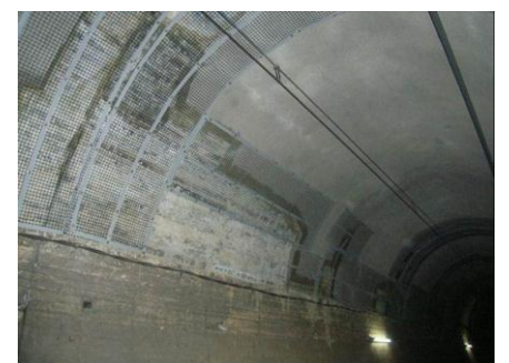
写真-2 トリカルネットによる対策
