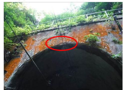
写真-4 レンガ造覆工剥落状況（遠景）
