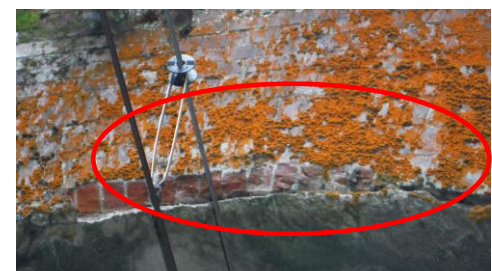
写真-4 レンガ造覆工剥落状況（遠景）
