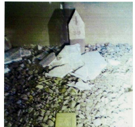
写真-1 吹付コンクリート剥落状況
