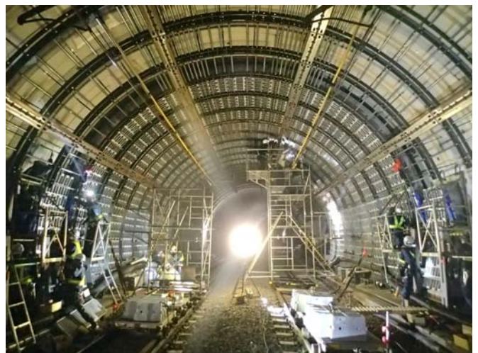
写真-2 セグメント組立状況
