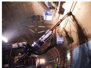
写真-4 ロックボルト打設
