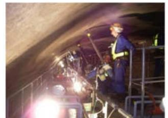
写真-2 削孔状況
