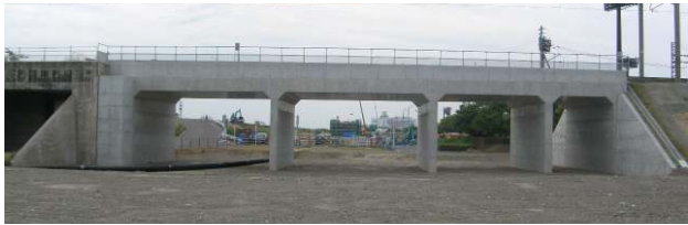
写真―1 全景写真
