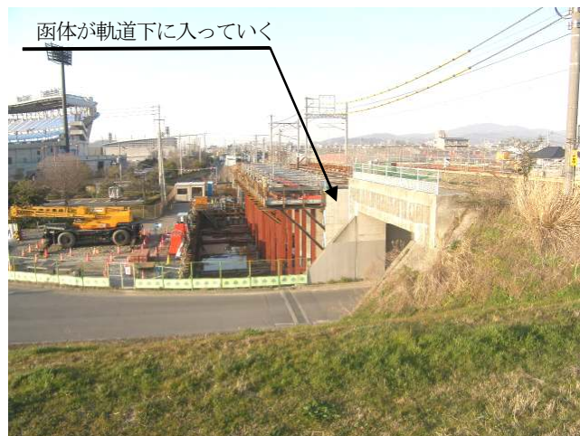
写真-3 函体けん引状況(発進立坑)
