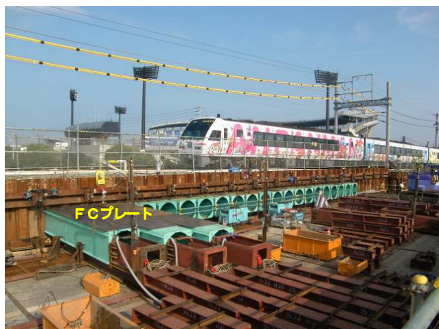
写真-2 上部箱形ルーフ推進状況
