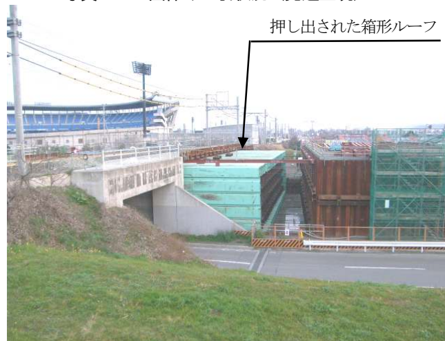
写真-4 函体けん引状況(到達立坑)
