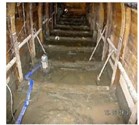
写真-1 ガイド導坑底盤部
