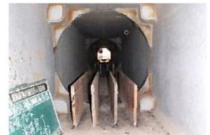
写真-2 ルーフ管内の補強
