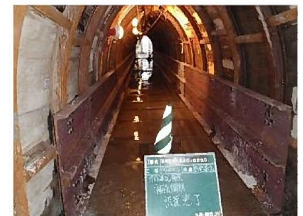
写真-3 ガイド導坑内の補強
