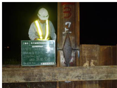
写真-5 鋼矢板の溶接状況
