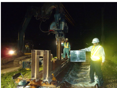
写真-4 鋼矢板の夜間打設状況
