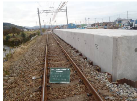
写真-1 新駅のホーム新設工事
