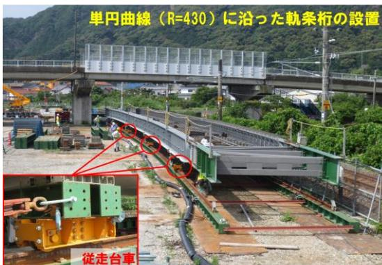
(写真3) 軌条設備設置状況 (送出しヤード)
