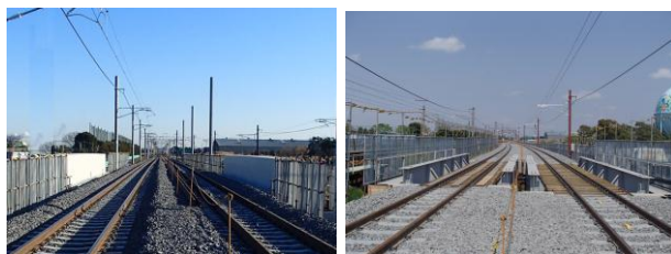
図-8 起点方から望む本線 PRC 桁部(左)と仮線工事桁部
