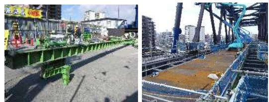
写真-2 ジャッキ架台 写真-3 高所作業車
