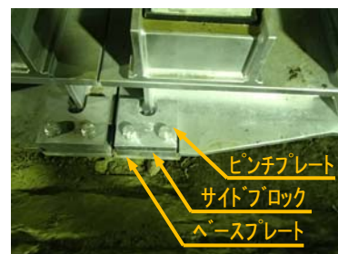
写真-1 新桁支承部（サイドブロック形式）
