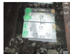
写真-2 支点プレート設置完了
