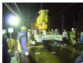
写真-3 桁架設状況
