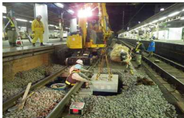
写真-1. プレキャストブロック設置状況
