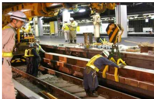
写真-2. 主桁設置状況
