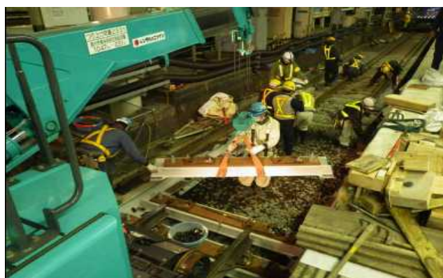
写真-3. 横桁設置状況
