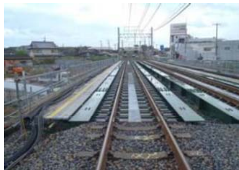
写真1 工事桁架設後
