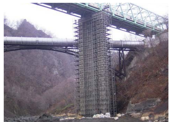
写真-2 枠組足場での施工例
