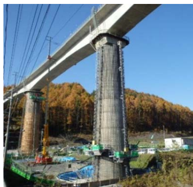
写真-5 移動昇降式足場 による施工状況
