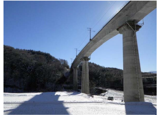
写真-1 今回施工の円錐形高橋脚
