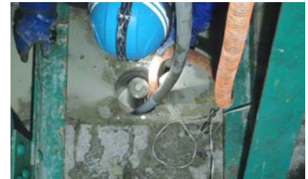
写真-5 高流動モルタル充填
