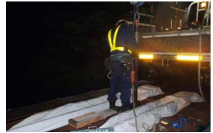
写真-4 鋼棒挿入
