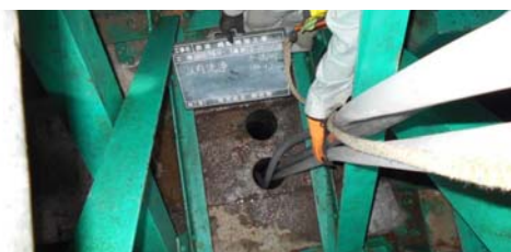
写真-3 孔内洗浄
