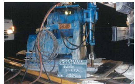
写真-6 注入改良状況
