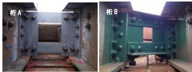
写真-1 新工法施工後
