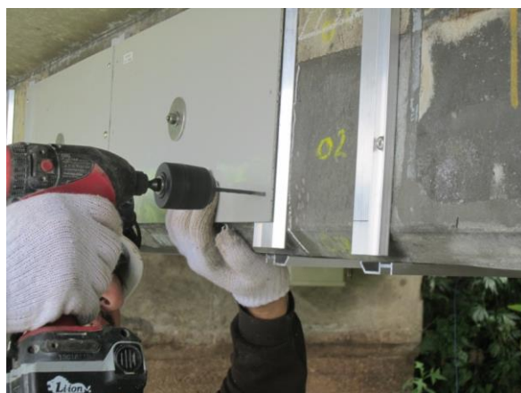
図-3 アルミニウム系流電陽極再設置状況
