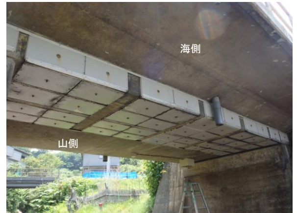
図-1 既設アルミニウム系流電陽極
