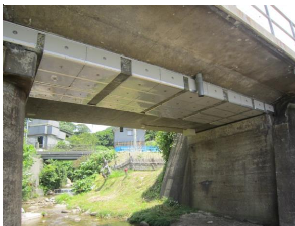
図-4 改良アルミニウム系流電陽極完成写真
