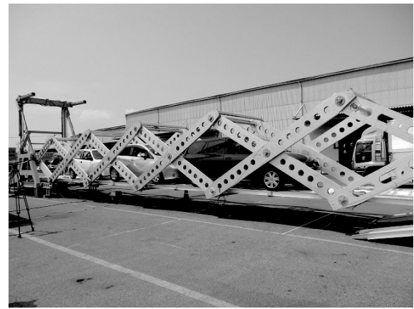
写真-2 折り畳める可搬展開橋「モバイルブリッジ (MB)」
