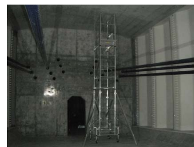
《桁内の点検用足場》
