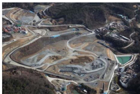
《高槻第一 JCT (東上空から)》
