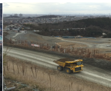
《35ton 重ダンプ運搬状況》
