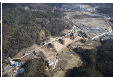
《高槻第一 JCT (西上空から)》
