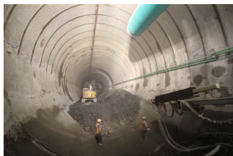
《WT 区間の掘削状況》
