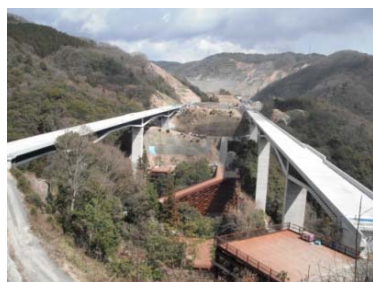
《下音羽川橋の全景》
